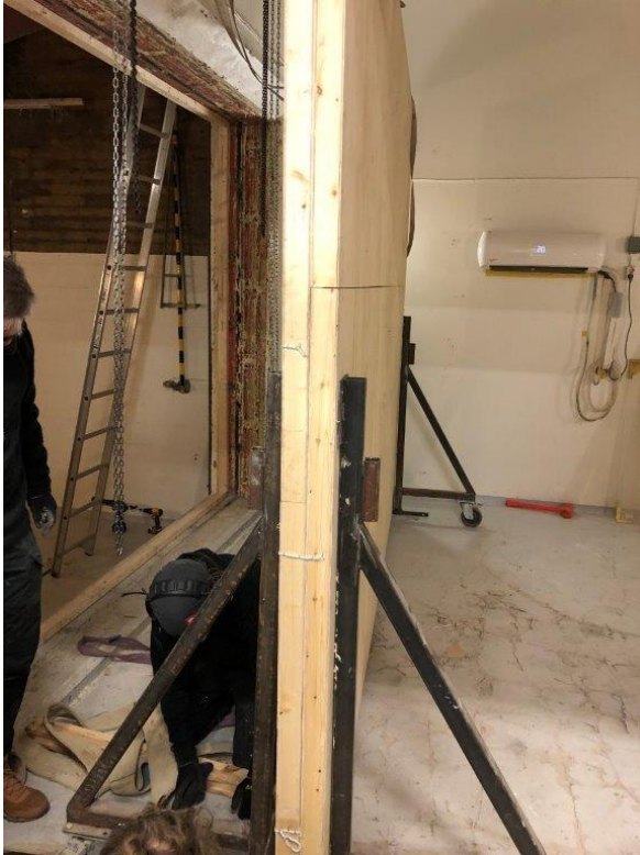
Figur 2: 120 mm Isotimber innan montage i väggöppning.
