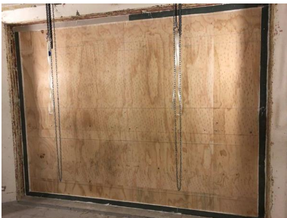
Figur 4: Isotimbervägg monterad i öppningen, sedd från sändarrummet.
