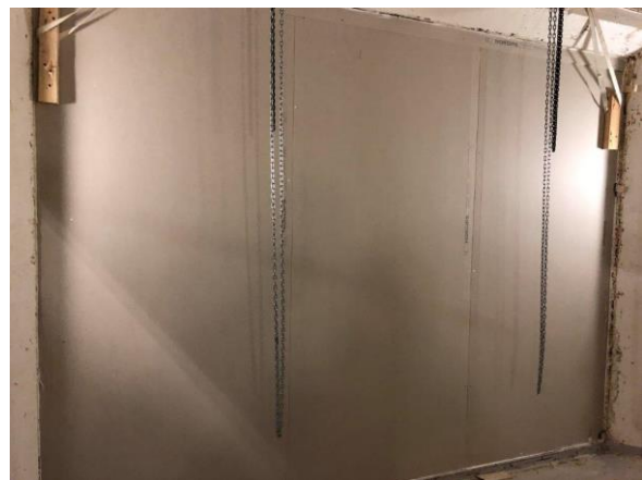
Figur 5: Väglösning med gips, sedd från sändarrummet.
