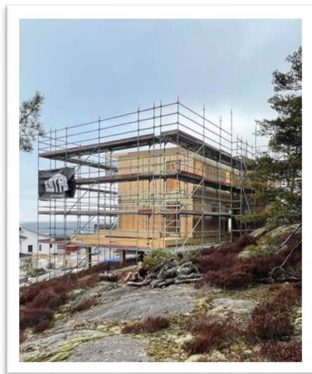
Figur 21 Byggställning behövs för det utvändiga arbetet, liksom personlig säkerhetslina .
