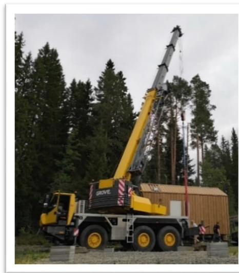
Figur 22 Kran med tillräcklig lyftkapacitet måste finnas på plats. Säkerställ att den får utrymme för manövrering och stabil grund.
