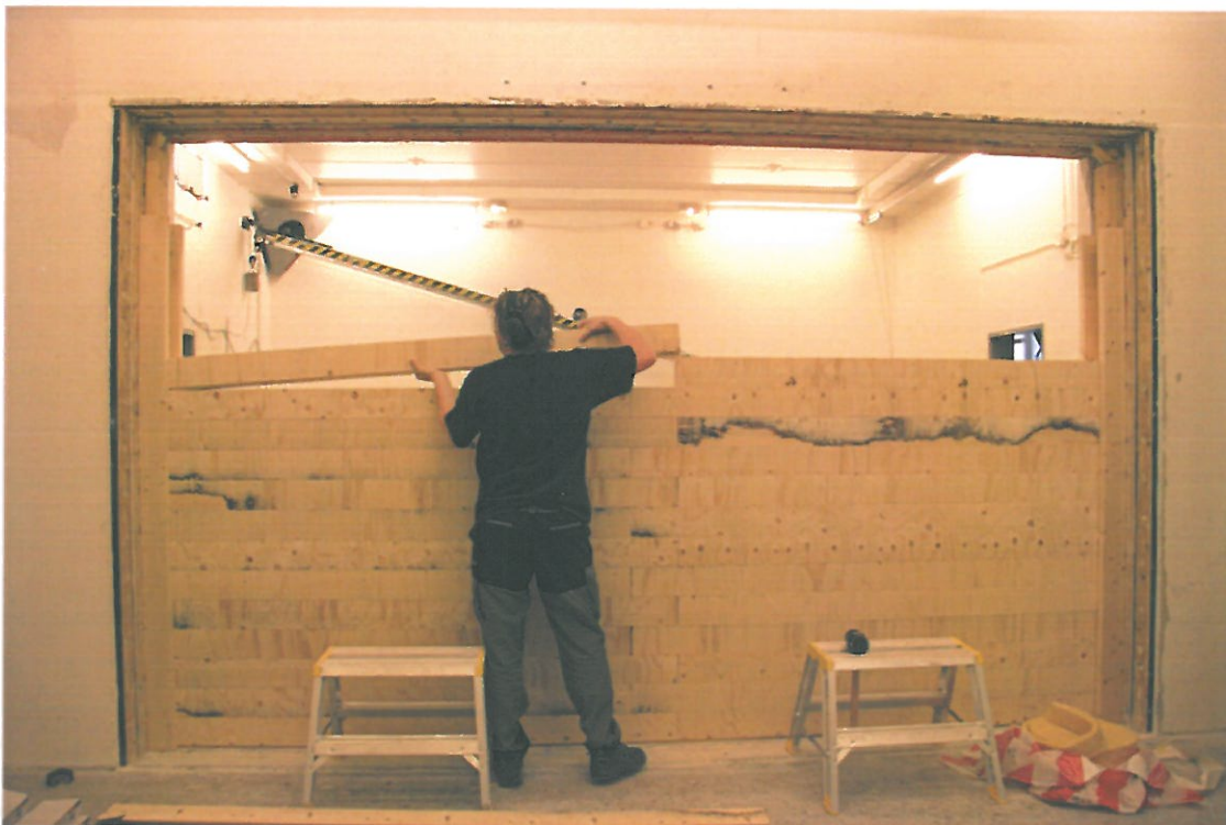
Bild 3 – Montering av Iso Timber trämodulkonstruktion. Fyra reglar användes som stöd under montaget. Skarvarna försköts c:a 300 mm vartannat skikt.
