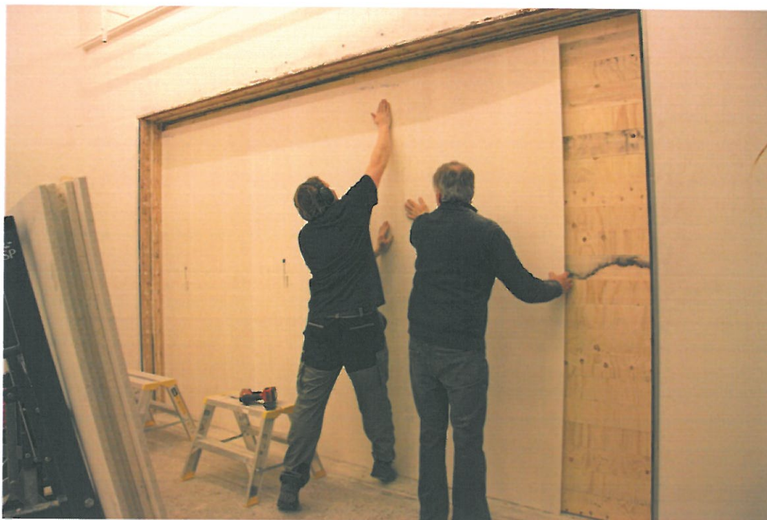
Bild 5 – Konstruktionen i bilaga 1 under montage. Magnesiumoxidskivor skruvades mot trämodulkonstruktionen.
