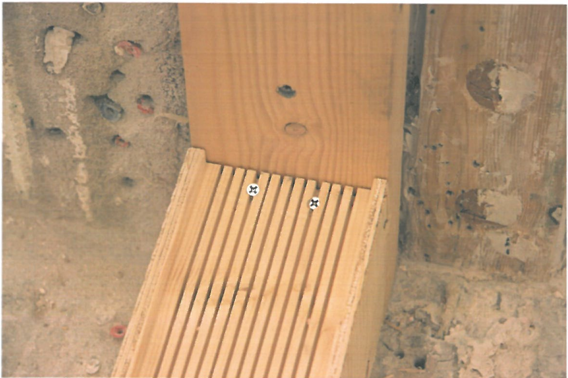
Bild 2 – Fästning av första skiktet trämoduler i regel.
