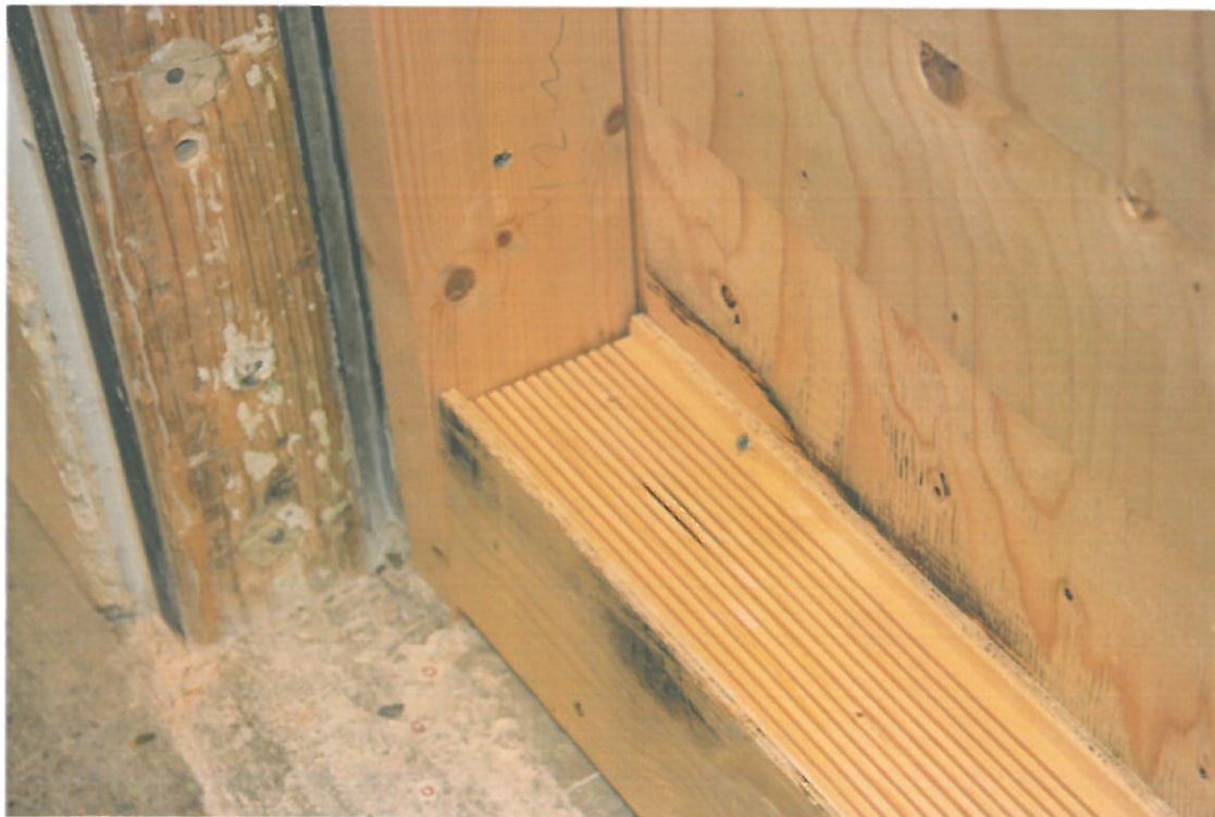
Bild 10 – Konstruktionen i bilaga 3 består av tre rader trämoduler som placerades utan avstånd mellan varandra och ett lager plywood på var sida om dessa.
