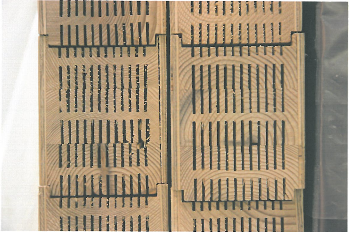
Bild 1 – Iso Timber trämodul som används i konstruktionerna i samtliga bilagor.
